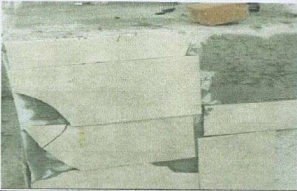
Foto 7: Azulejo de estufa rural en mal estado
